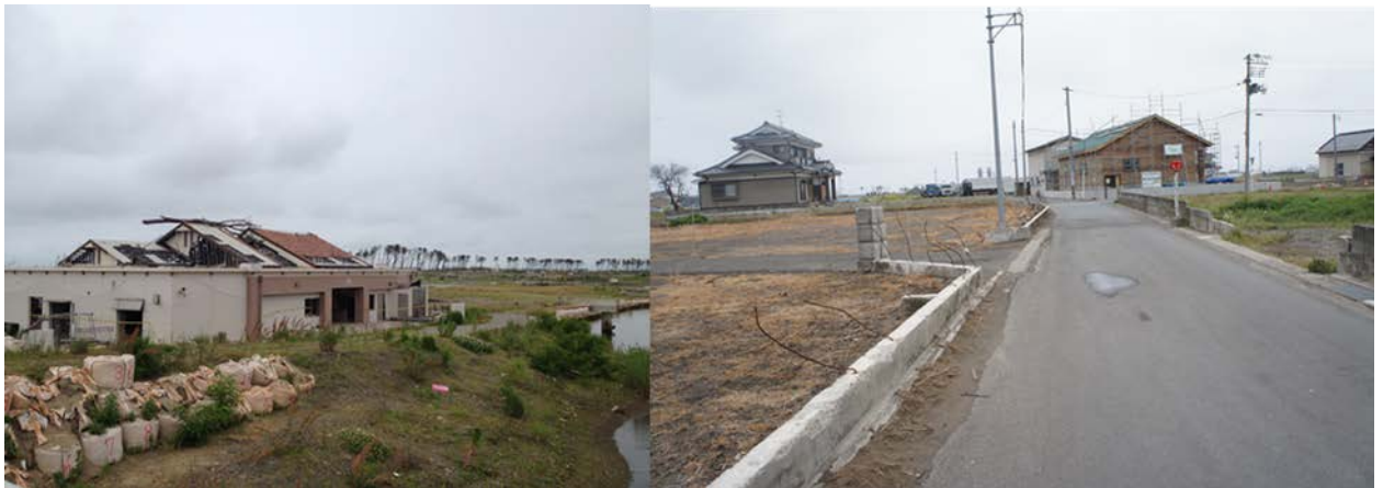
▲東日本大震災で津波の被害に遭った仙台沿岸部の様子
