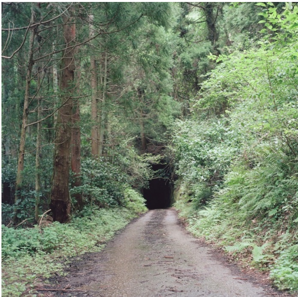
トンネルの入り口
