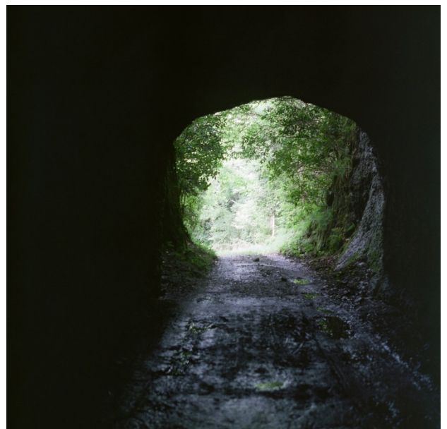
手掘りのトンネル
